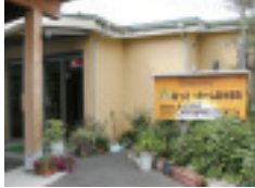
小規模多機能型居宅介護 あつと・ホームあけぼの 敷地面積 / 625㎡ 建物概要 / 木造平屋建 259㎡ 登録定員 / 25名 泊まり9名通い15名 訪問もいたします。
