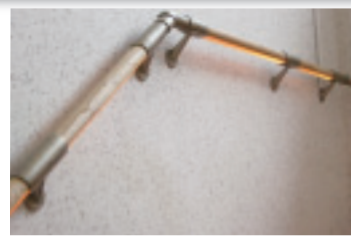
LEDライト手すりが全館に付けられている。
