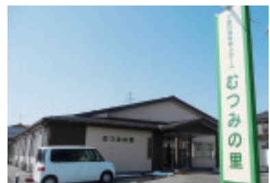
介護付有料老人ホームむつみの里は、国道8号線黒崎の大野大橋を三条方面に車で2-3分。利用定員は18名(全個室)。中庭を囲んで居室が配置されているため、陽光がふんだんに取り入れられている。
